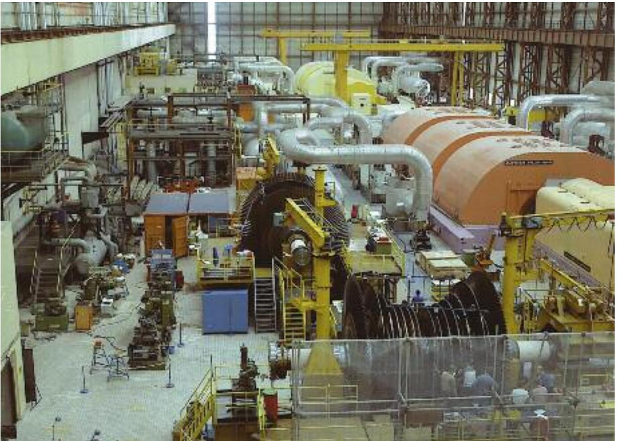
*Palier Turbines : rotors en maintenance au premier plan, turbines des tranches 1 et 2 en arrière plan.*
