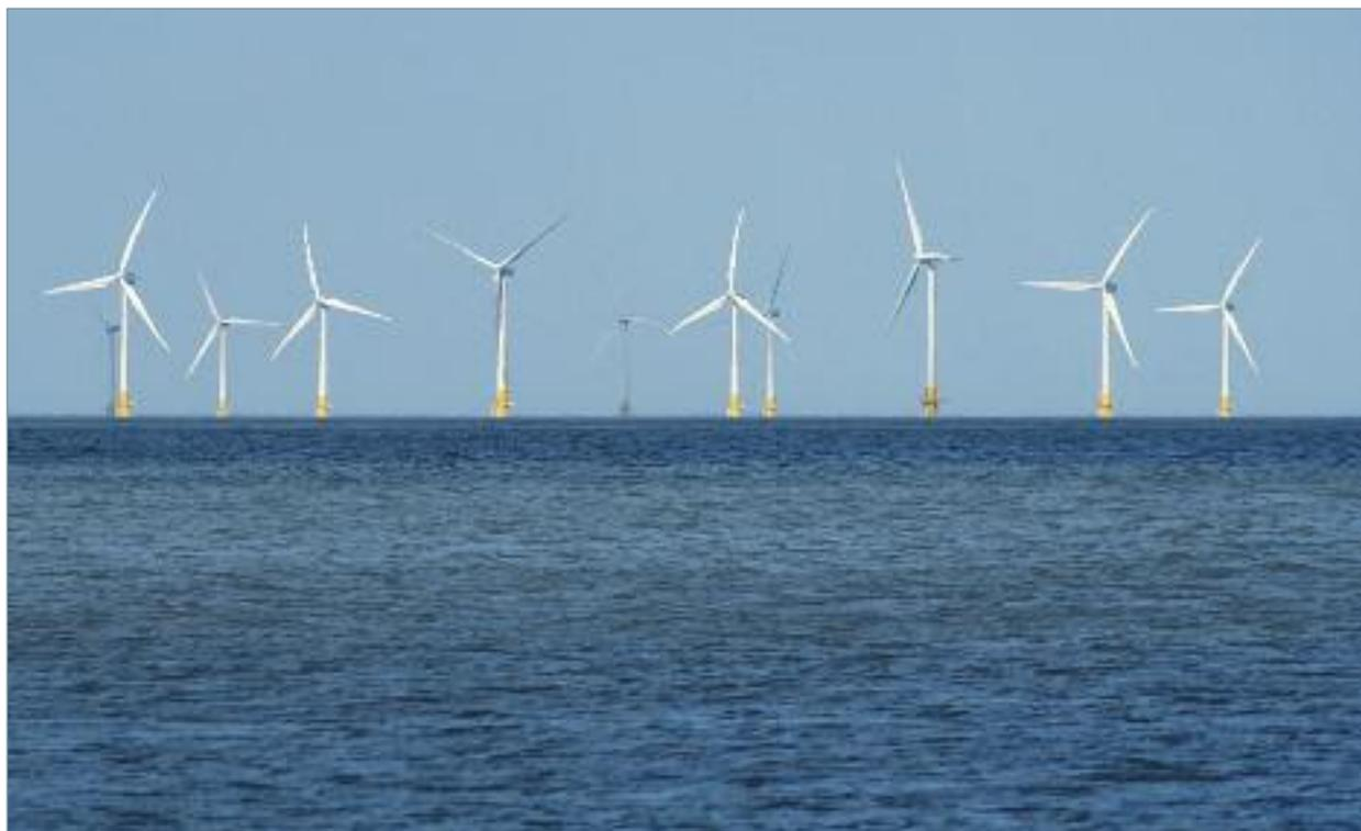
*Parc éolien offshore avec des fondations sur pieux métallique*
