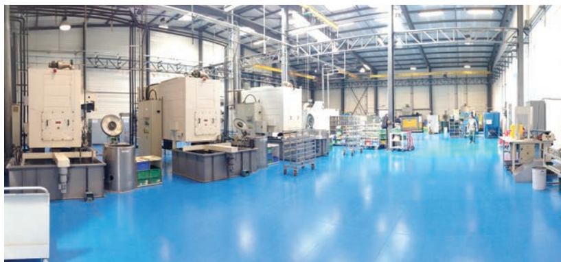
Salle des traitements thermiques des AHG
