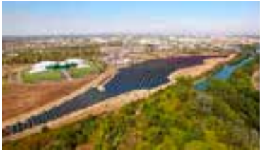
La ferme solaire d'Urbasolar qui alimente le site d'ArianeGroup
