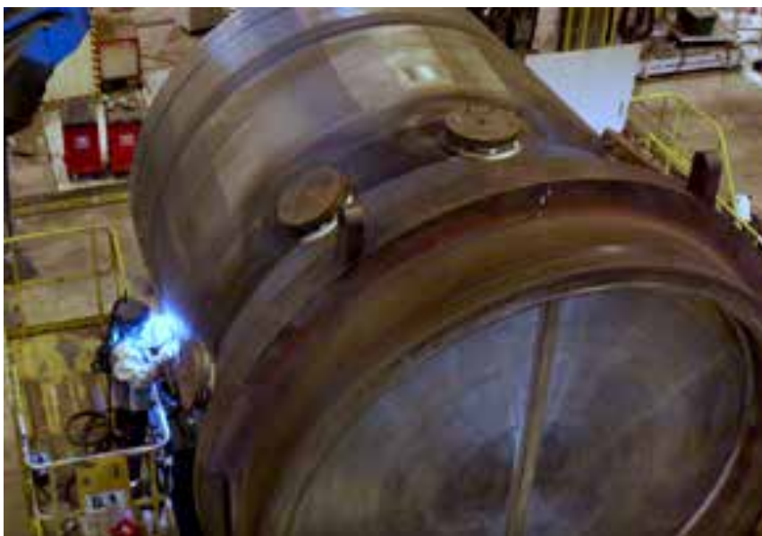
Soudage sur un générateur de vapeur
