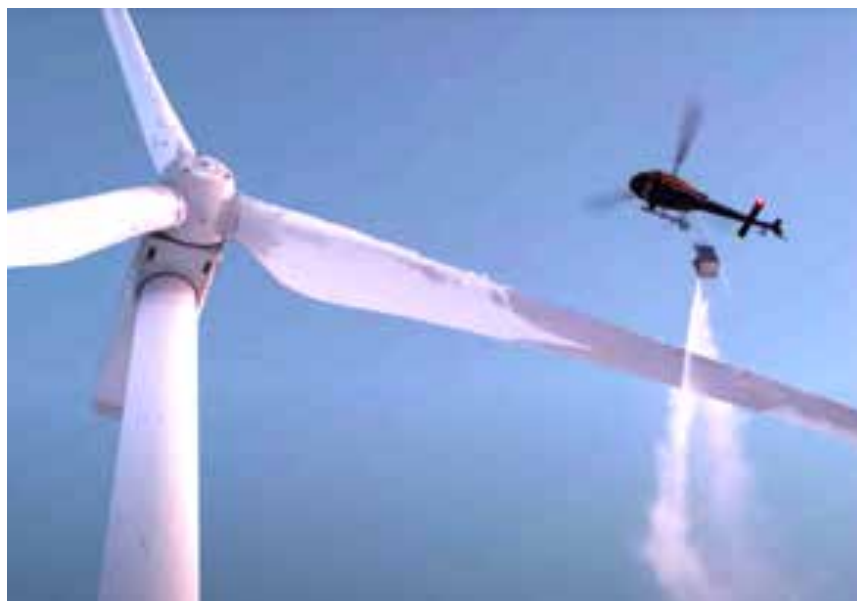
Figure 3 : Dégivrage d'une éolienne par hélicoptère. Cette situation semble cependant assez rare.
