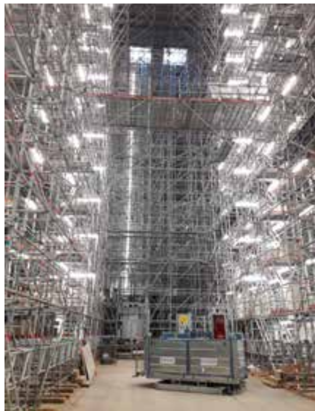
Une broussaille d'échafaudages pour consolider et restaurer
