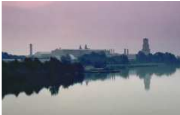
Vue du centre dans les années 1970. On y voit l'un des étangs au premier plan, le château d'eau à droite, le bâtiment B et les cheminées de ses chaudières au milieu, ainsi que la cheminée de la toute nouvelle chaudière du bâtiment C à gauche
