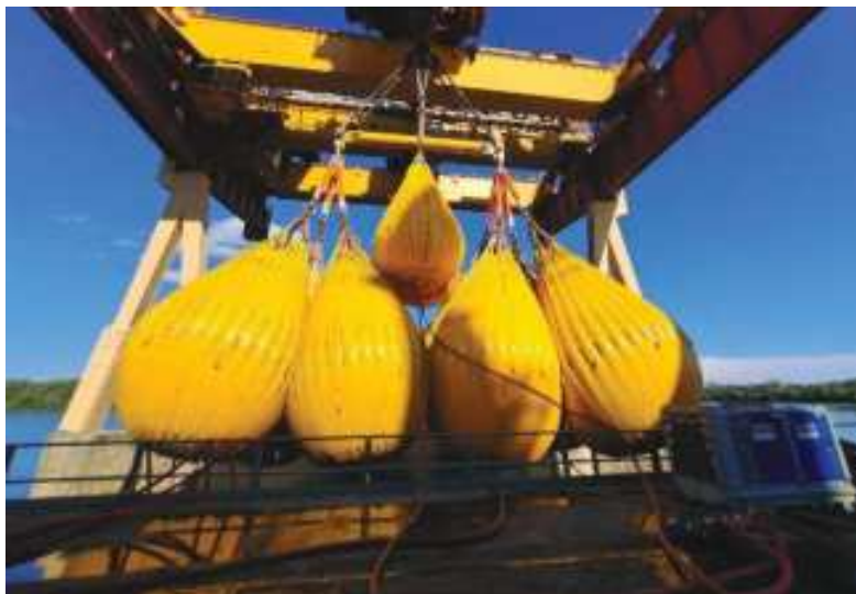
Essai en charge à 900 tonnes pour valider la réparation du pont
