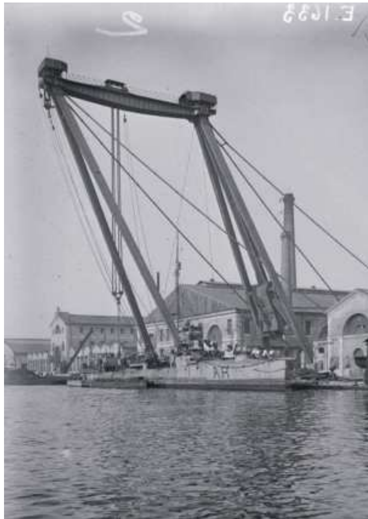
Figure 1 : Le contre-torpilleur Arc faisant enlever ses chaudières pour être réparées, à Toulon 16 août 1916. SPA/SPCA Amédée Eywinger/ECPAD/Défense
