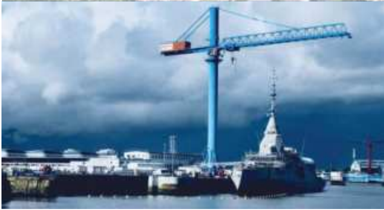
Le chantier de Naval-Group au cœur de l'agglomération lorientaise
