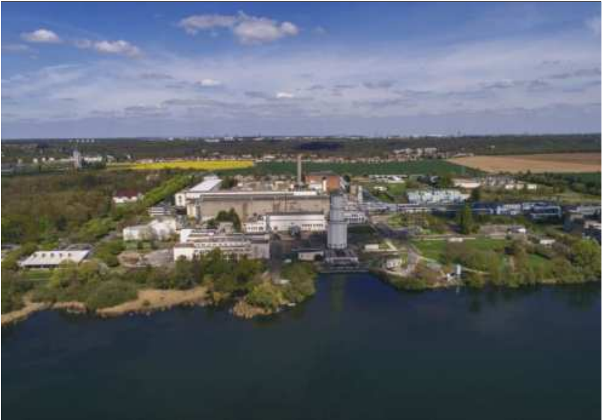
Vue actuelle du centre. On retrouve l'étang et le château d'eau au premier plan ainsi que la cheminée du bâtiment C au second plan. À droite, on devine le poste haute tension et la ligne électrique qui longe le centre. Enfin, on peut remarquer l'urbanisation croissante du plateau à l'arrière-plan
