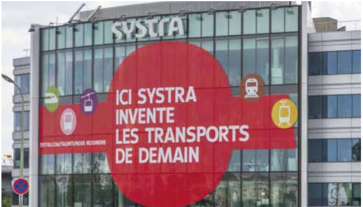
Le siège de Systra vu du périphérique Porte de Sèvres
