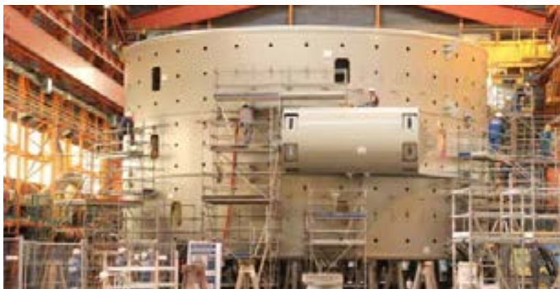
Assemblage sur le site DCNS de Brest des 2 hydroliennes qui équiperont la ferme expérimentale de Paimpol-Bréhat.
