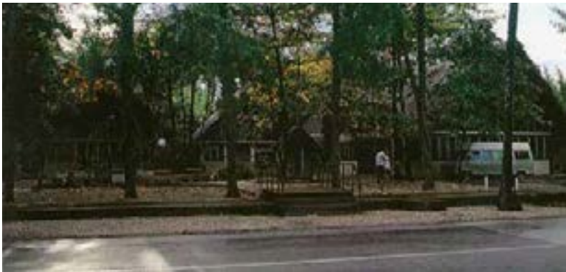
Restaurant Tiaré Village pour le personnel du CEA et Entreprises sous traitantes... 4 Etoiles.
